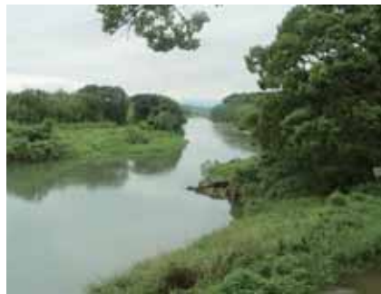
矢部川は現在も自然堤防のままの護岸が多く残る。
